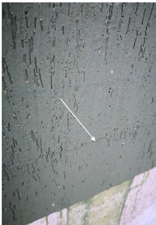
PHOTOGRAPHIE N° 3 : FISSURE HORIZONTALE PANNEAU VERTICAL / SOUBASSEMENT DU VIDE TECHNIQUE
