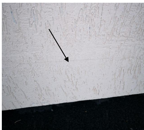
PHOTOGRAPHIE N° 2 : FISSURE HORIZONTALE ENTRE PANNEAU VERTICAL ET RADIER
