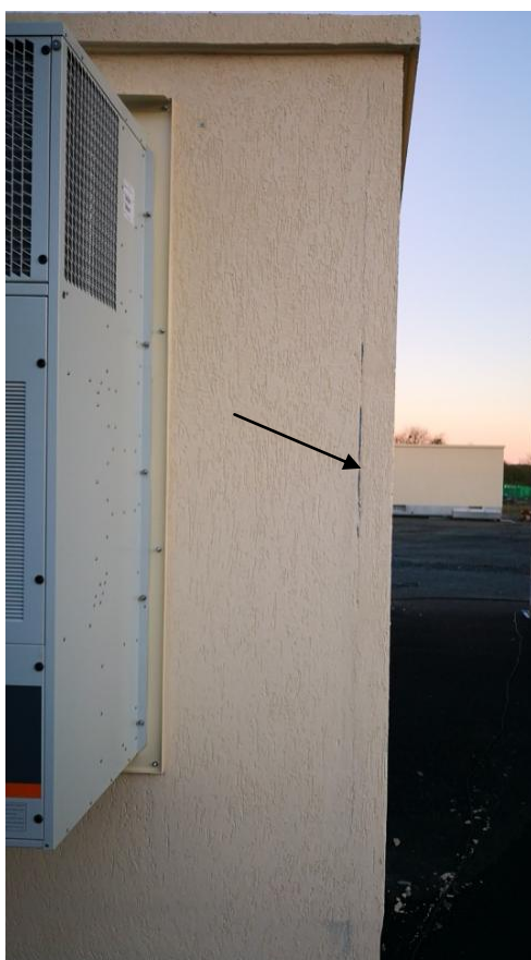
PHOTOGRAPHIE N° 1 : FISSURE VERTICALE ENTRE PANNEAUX VERTICAUX
