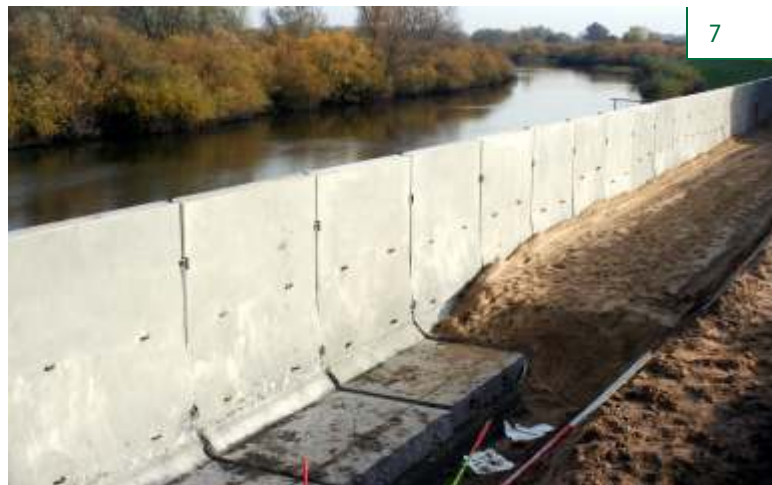
Protection des rives
