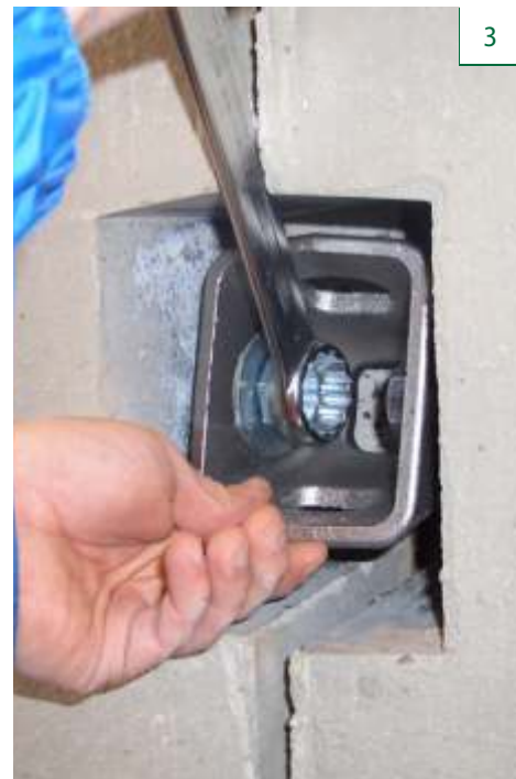
Fixation avec clé à cliquet
