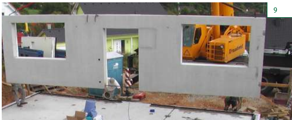
Assemblage mur et dalle
